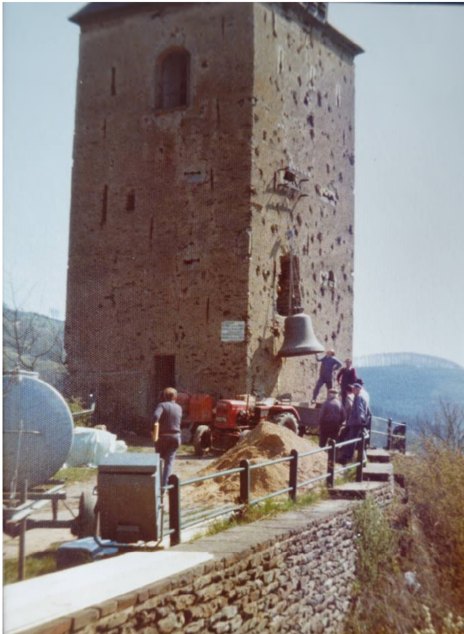
Abb. 2: Fotoaufnahme vor 1977 während des Einbaus der neuen Glocke und der damit verbundenen großen Maueröffnung. (Quelle: Fotoarchiv der Gemeinde Vianden)
