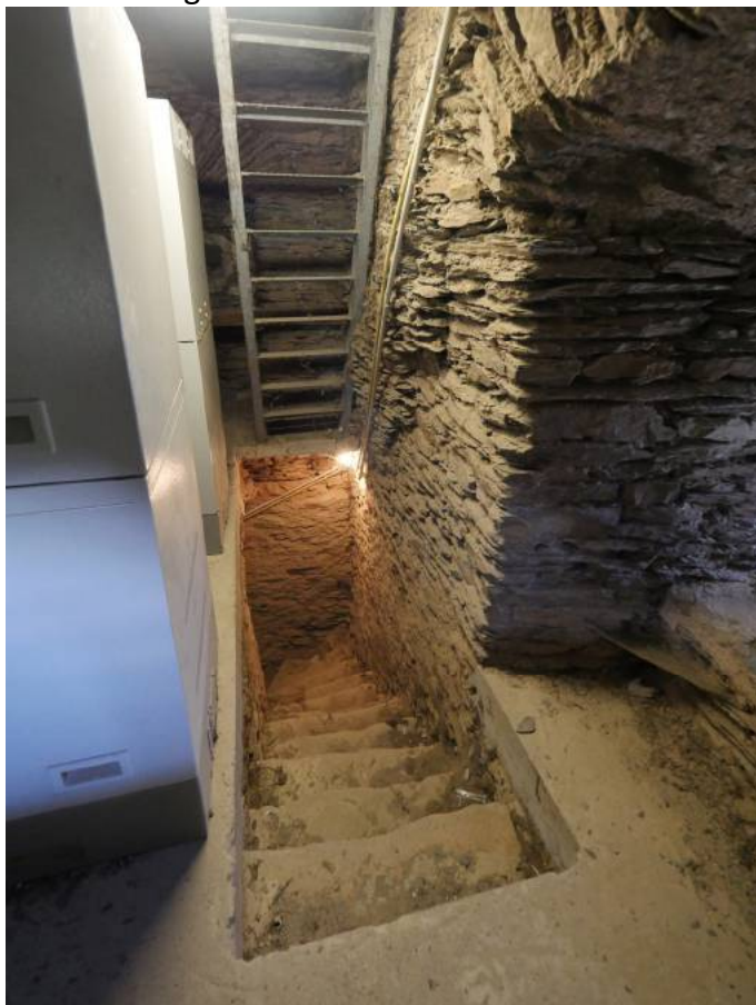
Abb. 12: Treppe zum 1. Obergeschoss.
