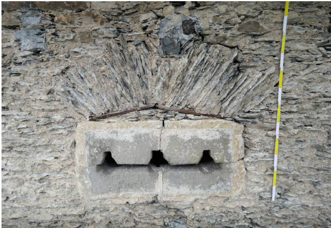
Abb. 9: Bauzeitliche Schießscharte im 2. Obergeschoss.
