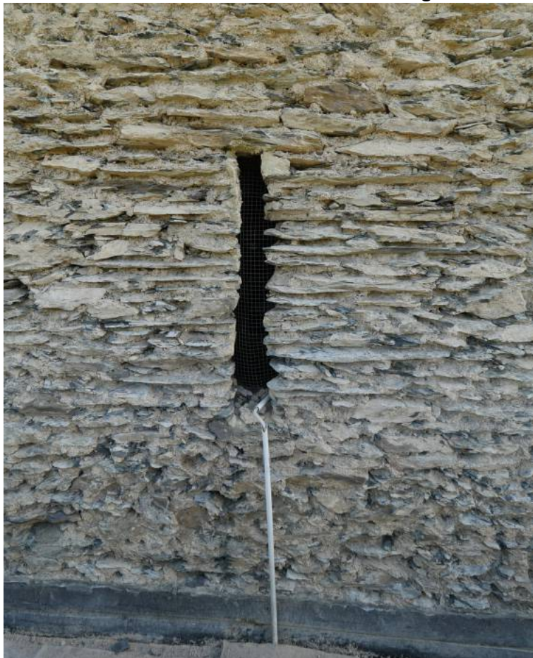
Abb. 10: Bauzeitliche Schlitzscharte im 3. Obergeschoss.
