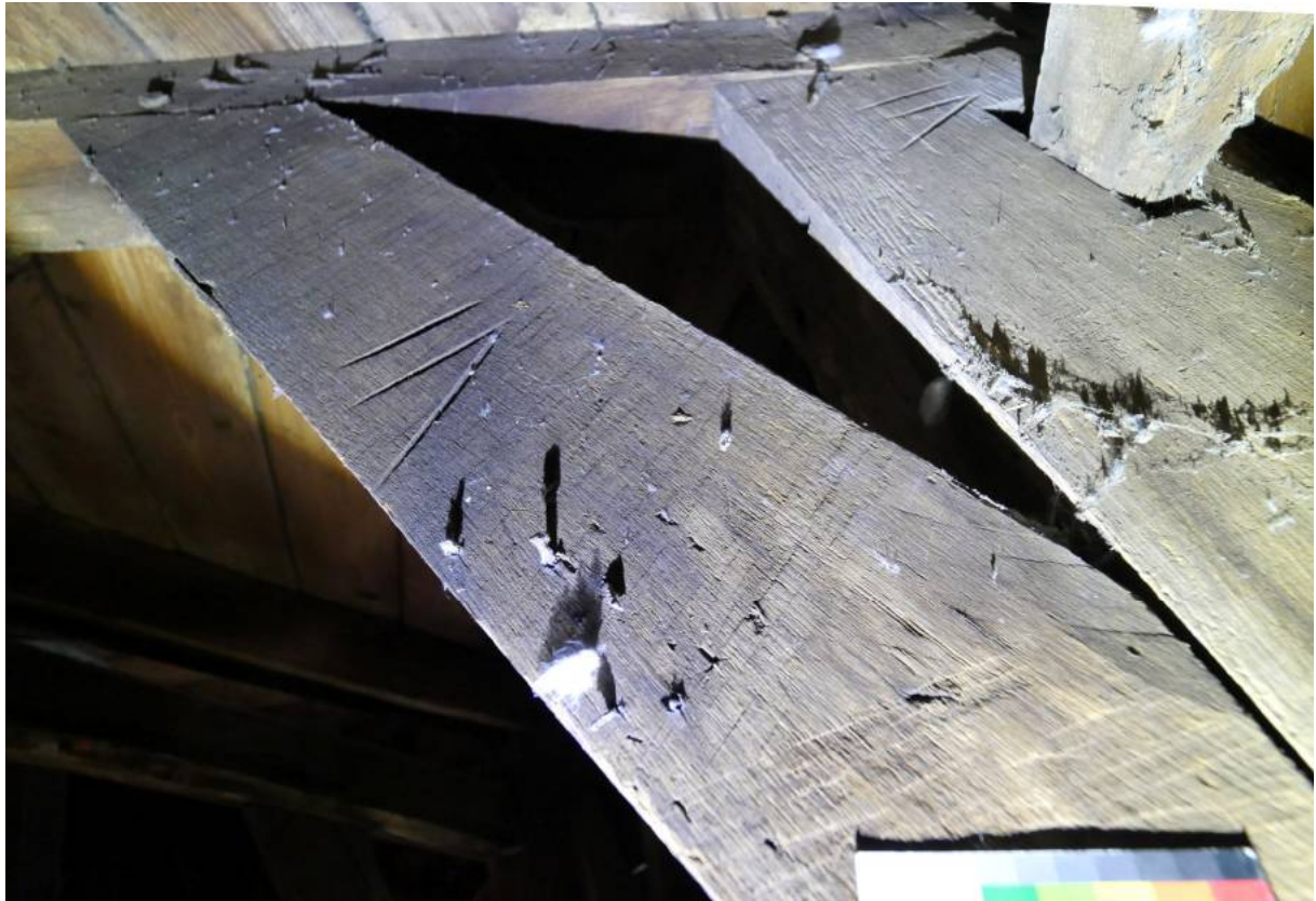
Abb. 18: Abbundzeichen des Dachwerks.
